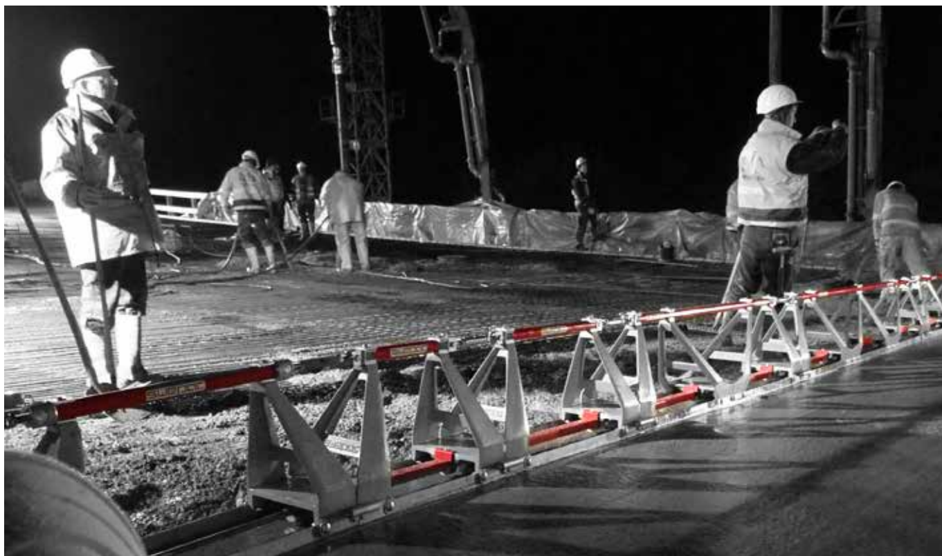
Specjalny zestaw sprzęgłowy do uzyskiwania większych spadków w porównaniu do standardowych połączeń
